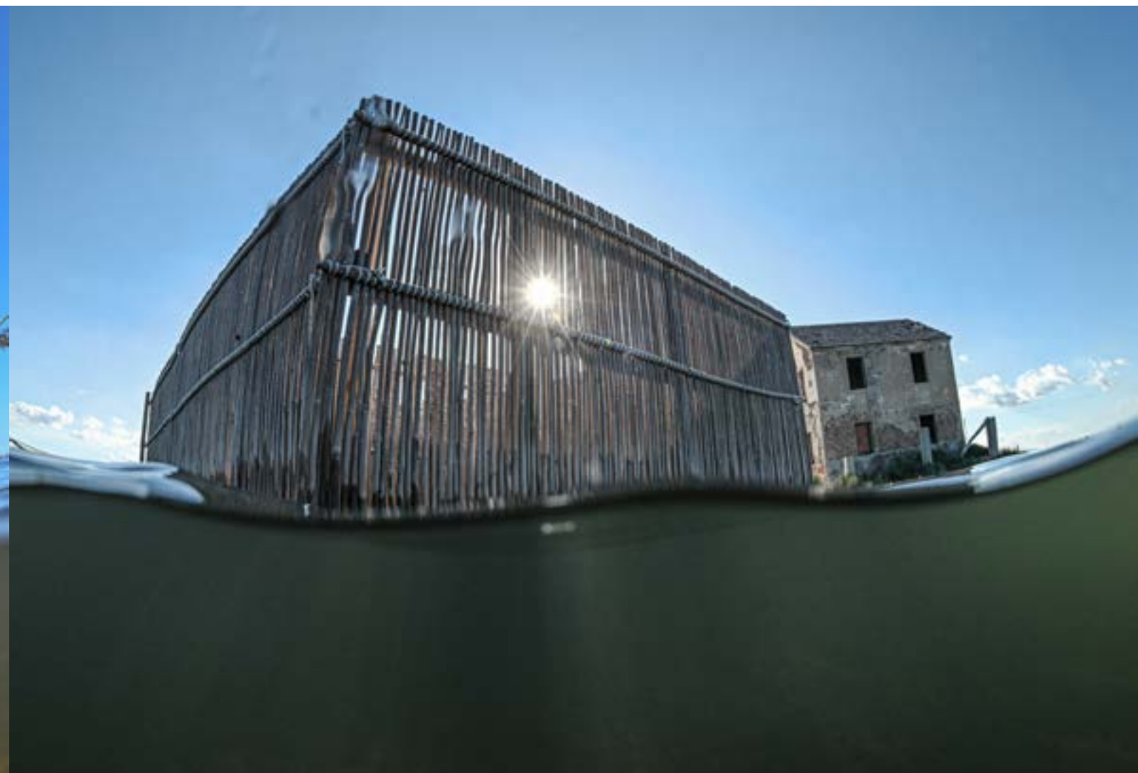
Detalle de la paranza y del edificio de la Encañizada del Ventorrillo, que fue construido en 1970 y tiene unos 90 m 2 .
